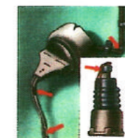
Неисправность электропроводки Пользование самодельными предохранителями
